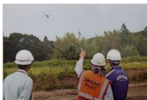
ドローンを使った 現場確認
