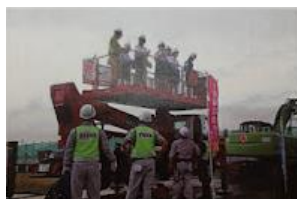
高所作業車に乗っての 現場説明
